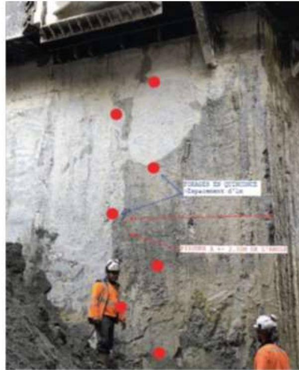
Apparition de la fissure le 02/10/2019 : injection résine polyuréthane aqua-réactive à travers des forages en quinconce.
